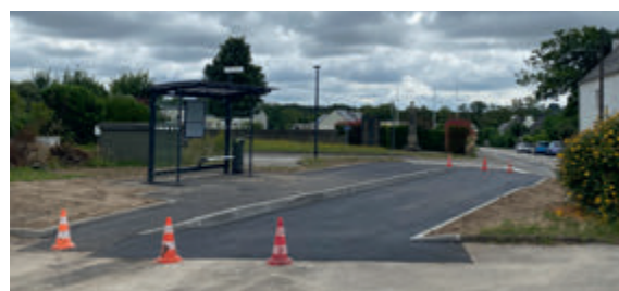
Photo des travaux de l'entreprise Colas pour implantation de l'arrêt de bus du terminus (incluant une voie d'entrée pour le bus)
