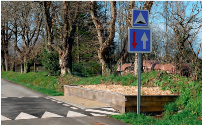
Le Hallate, réhausseur avec bacs latéraux végétalisés
