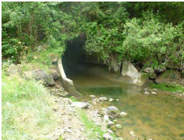
Photo 2 : Tunnel sous la RN165
