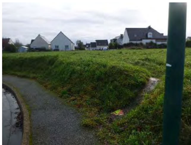
Accès depuis le rond-point
