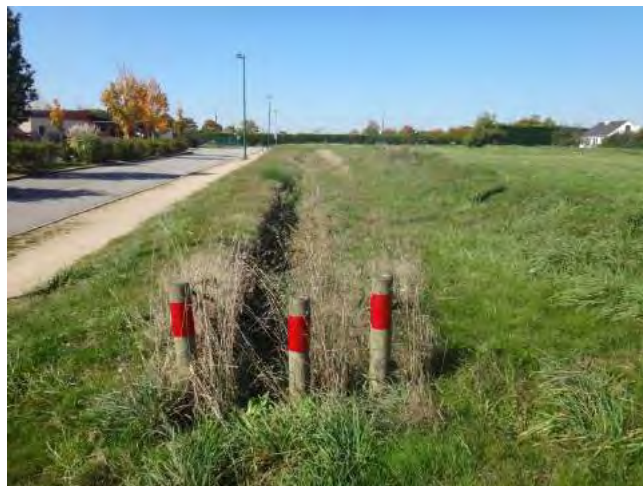
Tranchée le long de la rue du roi Stivan
