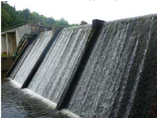
Photo 1 : Barrage de Pont Sal - supprimé
