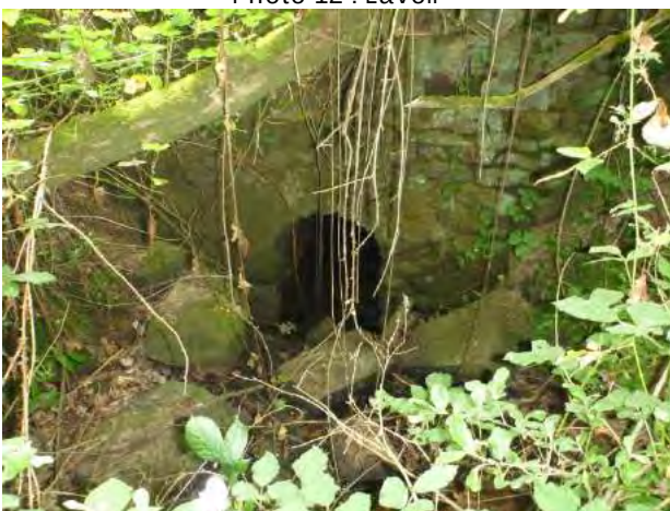
Photo 14 : Route de Bodaval
